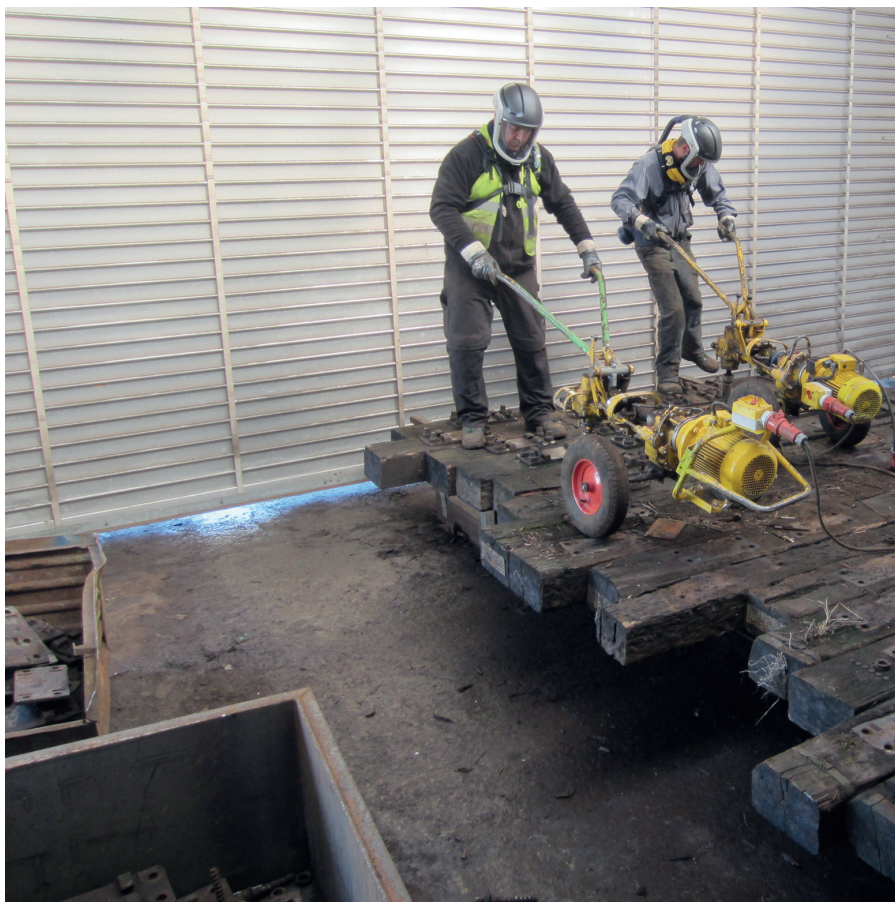
Manuelles Abplatten von Bahnschwellen
