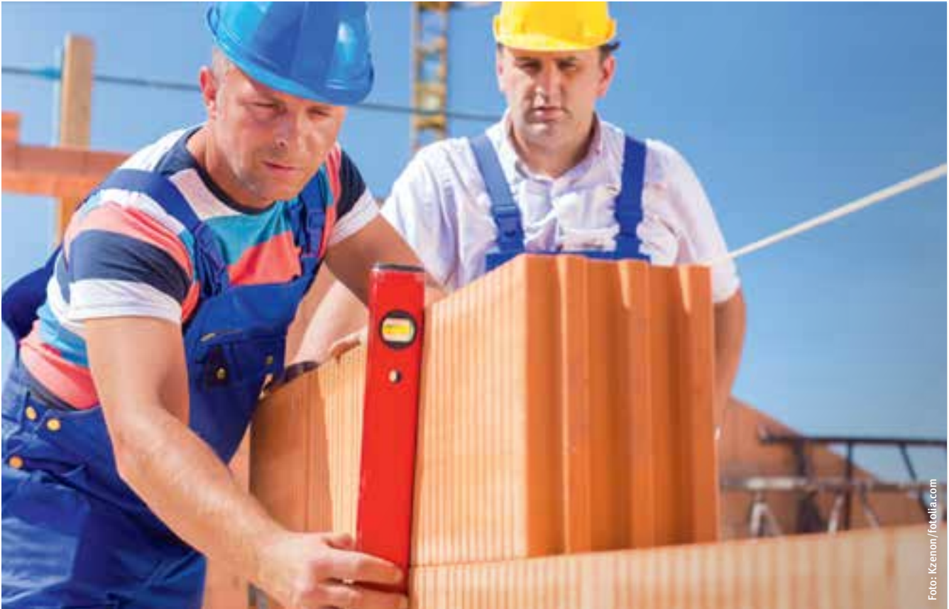
Bauarbeiter sind natürlicher UV-Strahlung ausgesetzt und damit hautkrebsgefährdet.
