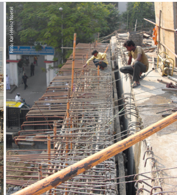
Bewehrungsarbeiten bei einem Brückenbauwerk
