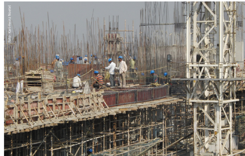
Bau eines Hochhauses in Mumbai
