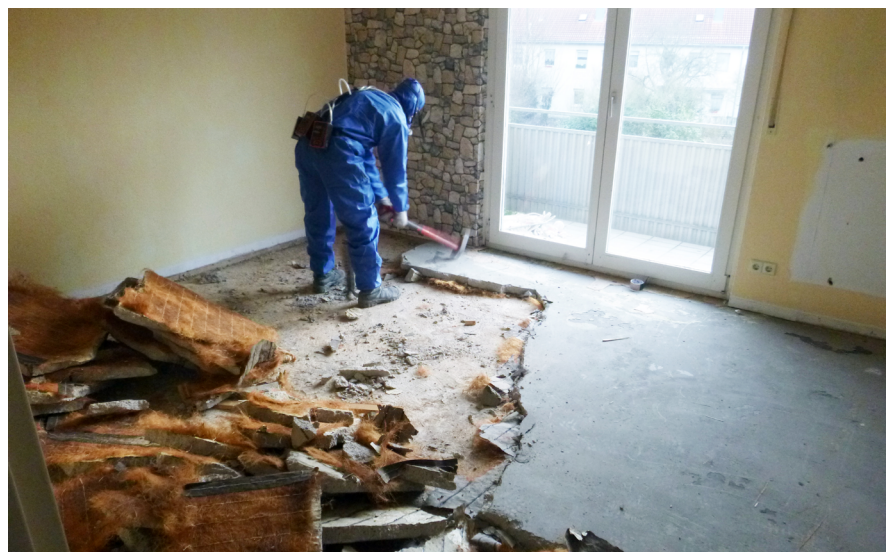
Abbildung 2: Hoher Aufwand auf Abbruchbaustellen: Die händische Demontage schadstoffbelasteter Bausubstanz.
