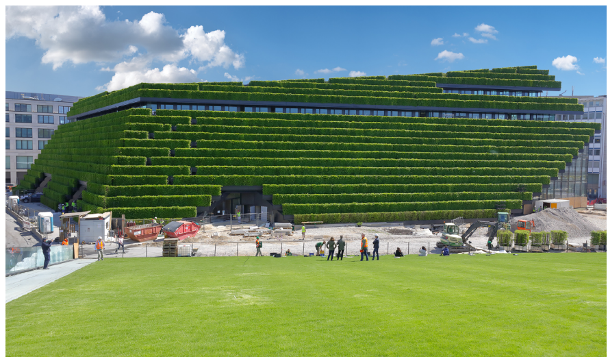
Abbildung 1: Kö-Bogen II – Fassadenbegrünung zur Bindung von Feinstaub und CO 2 und als natürliche Klimaanlage, weil die Hainbuchenhecke als Hitzepuffer für das innerstädtische Klima fungiert. ➔ www.leonhards.de
